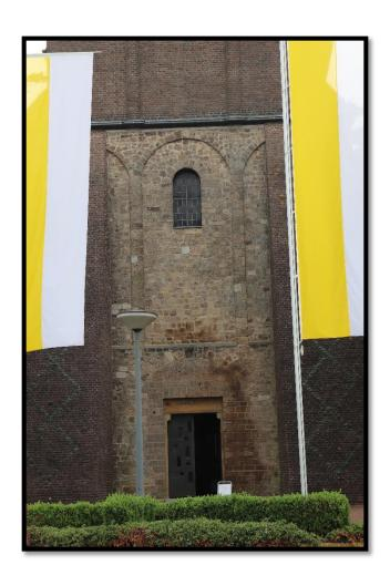
Türeingang der Kirche mit einer Türumrahmung, die von zwei Kopfkonsolen getragen wird. Der Sturz ist mit einem tauartigen gedrehten Dreiviertelstab geschmückt.
